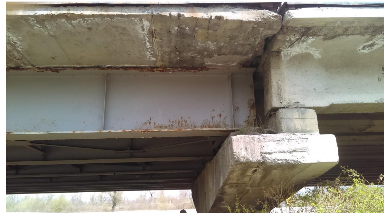
ფოლადის და ბეტონის მალის ნაშენის უხარისხო გადაბმა
