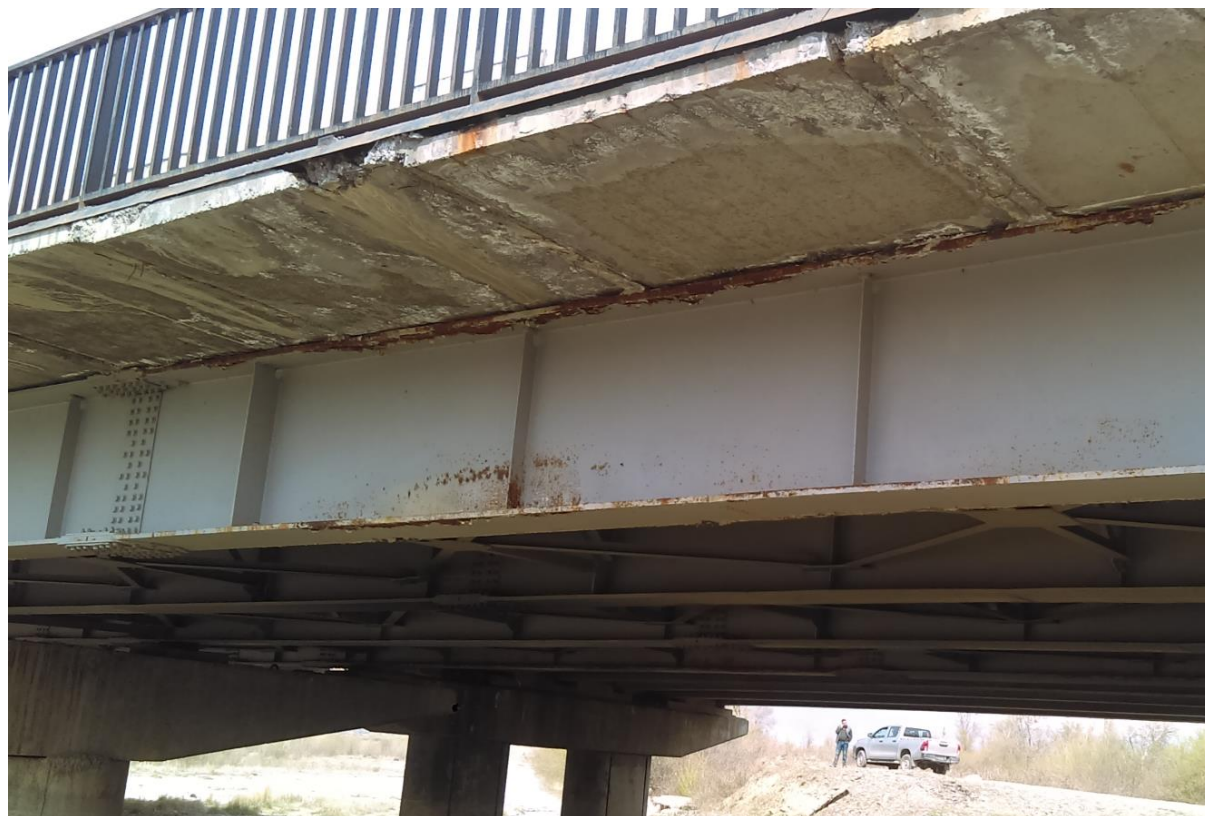
სავალი ნაწილიდან და არმატურიდან ჩამონადენი წყლით დაზიანებული ფოლადის კოჭი,
