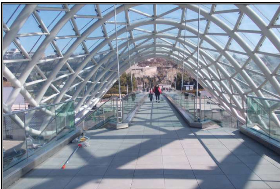
ფოტო 3. ხიდზე არსებული ვერტიკალური წრიული კვეთის ( \varnothing=3.50 მ) საკიდების განლაგება
