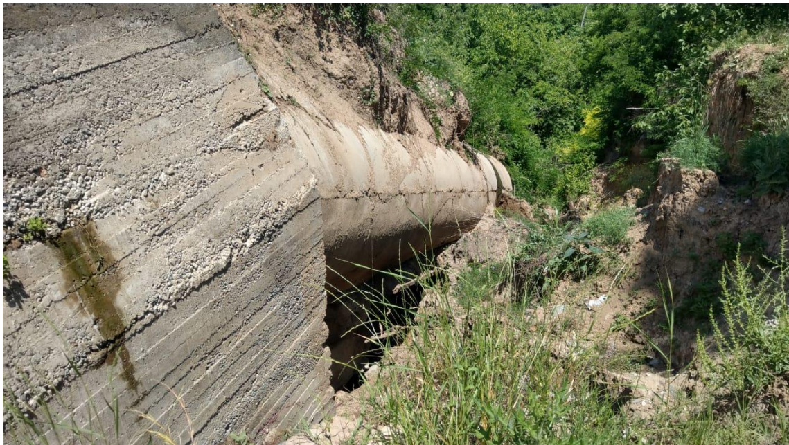
სურათი 1 - ჩარეცხილი ფერდი (სიღრმე 6-7მ) და დიუკერის გაშიშვლებული მარჯვენა გვერდი
