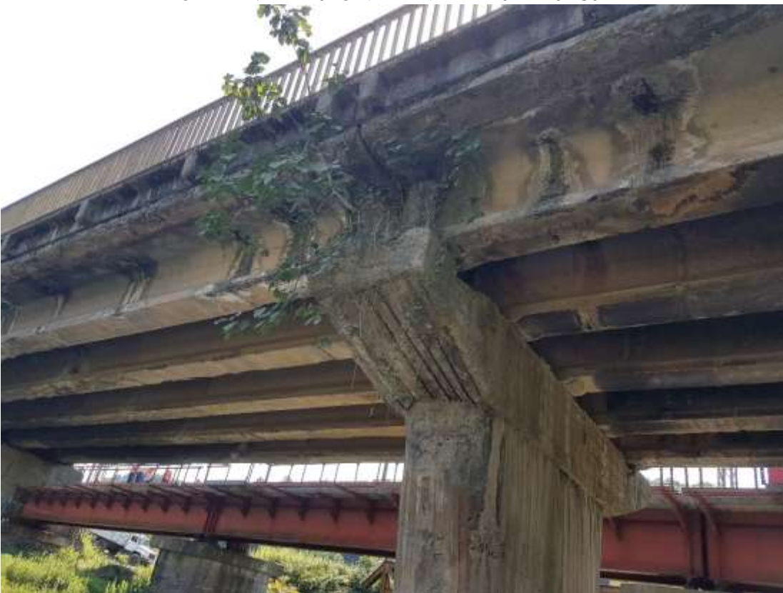
სურ. 5. დაზიანებული მალის ნაშენის კოჭები
