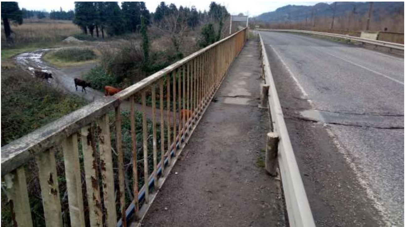
სურ. 1. დაზიანებული ტროტუარის ბლოკები და კოროზირებული მოაჯირები
