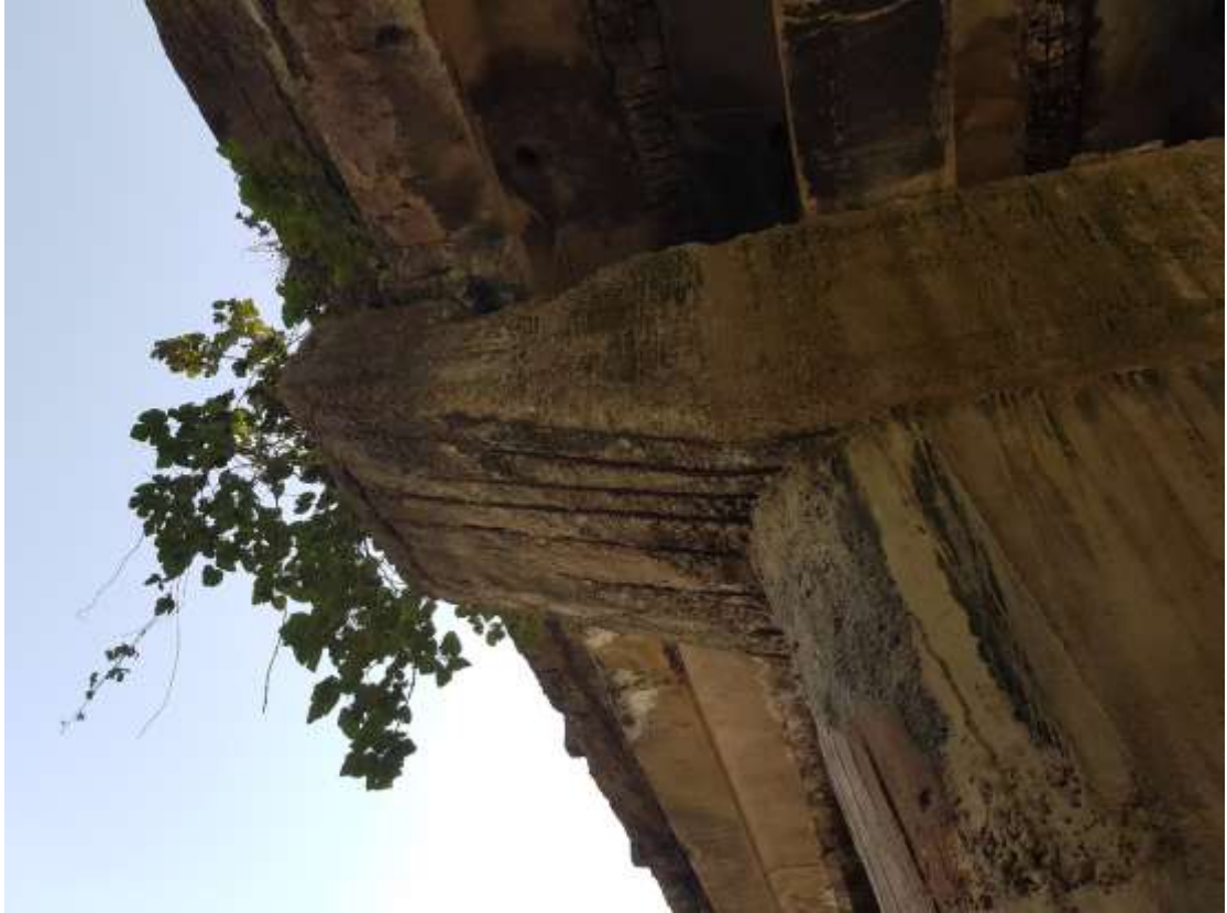
სურ. 6. შუალედი ბურჯების გამოფიტული ბეტონის დამცავი ფენა
