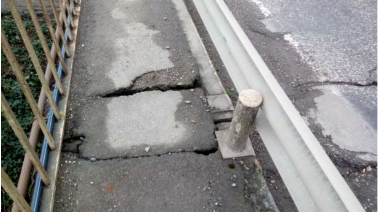
სურ. 2. დაზიანებული ტროტუარის ბლოკები
