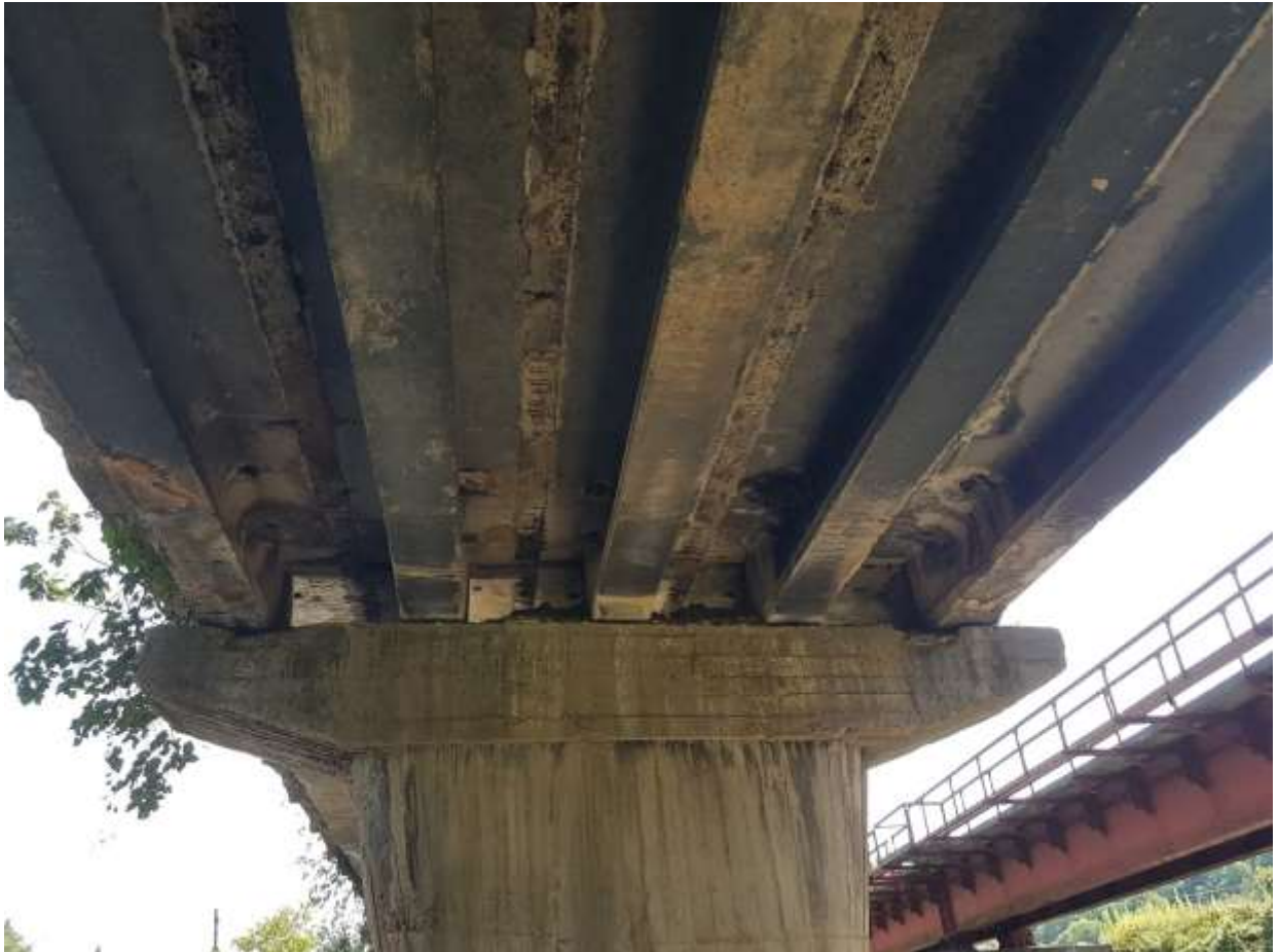
სურ. 3. დაზიანებული მალის ნაშენის კოჭები
