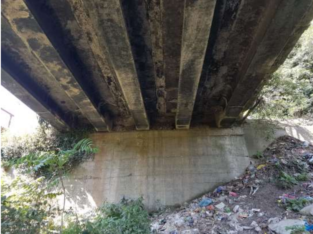
სურ. 4. დაზიანებული მალის ნაშენის კოჭები
