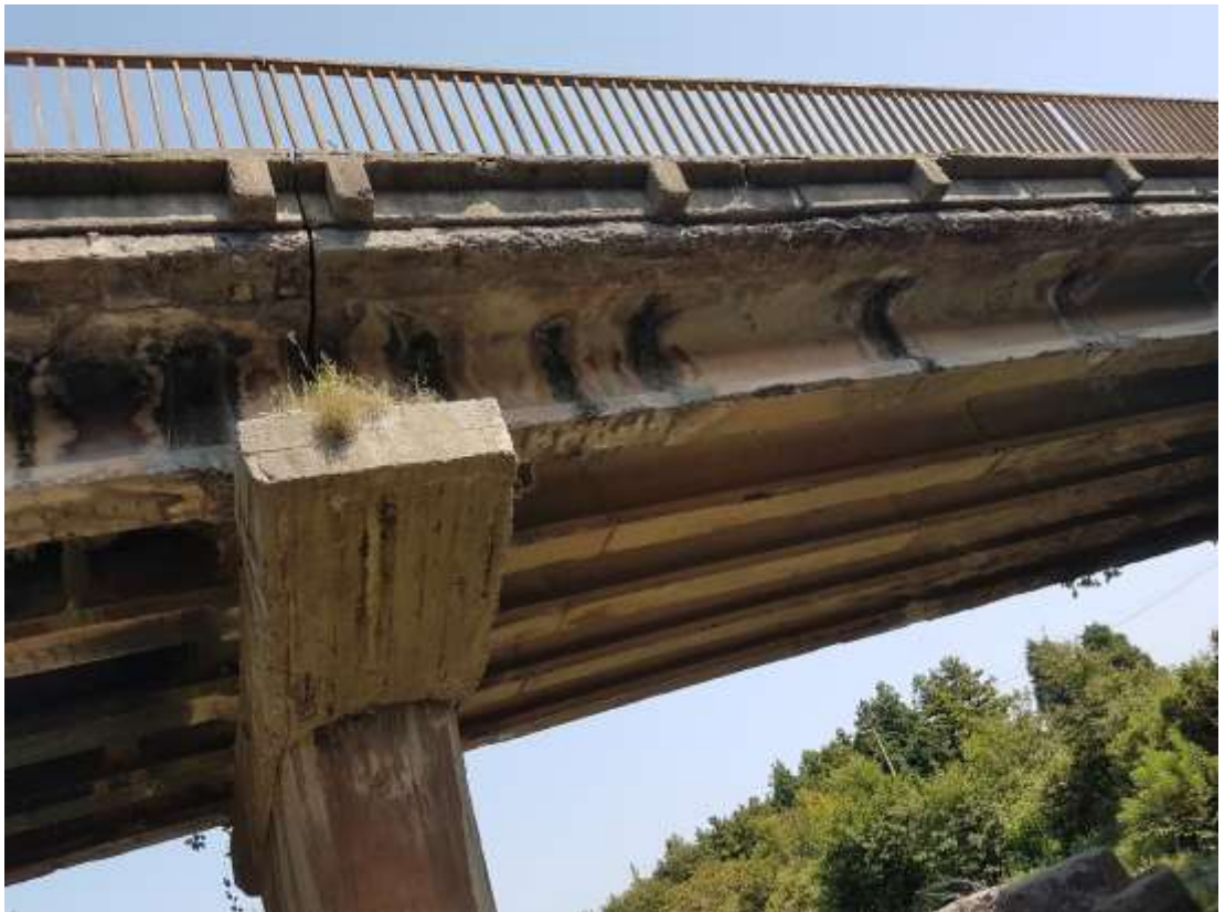
სურ. 7. შუალედი ბურჯების გამოფიტული ბეტონის დამცავი ფენა
