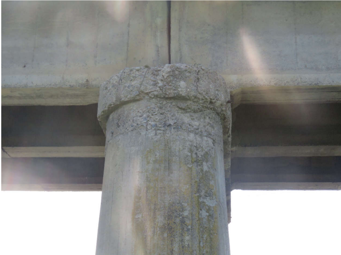
სურ. 5. ფერმისქვეშა ფილების გამოფიტული ბეტონი
