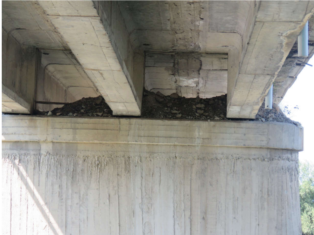
სურ. 1. შუალედი ბურჯების დანაგვიანებული ფერმსქევა ფილები
