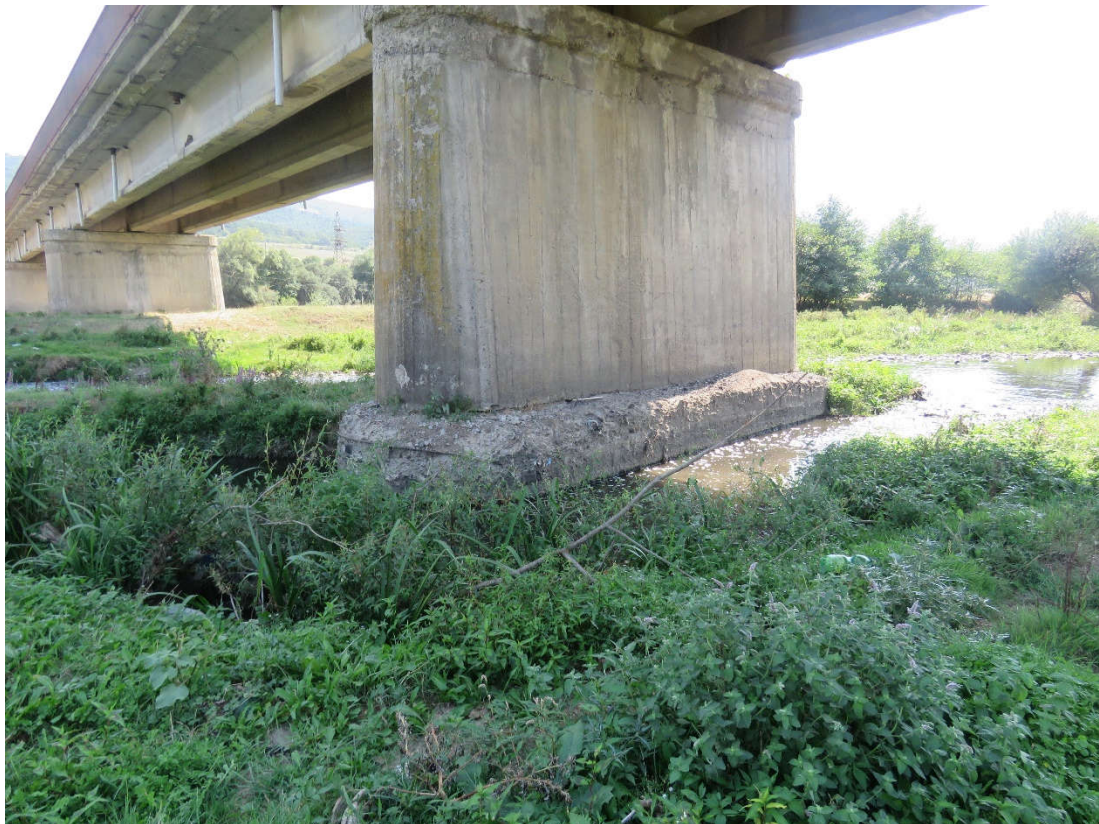
სურ. 4. ჩასაშვები ჭის გამოფიტული ბეტონი
