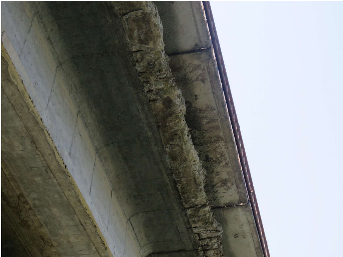
სურ. 6. დაზიანებული გამონოლითების ნაკერები
