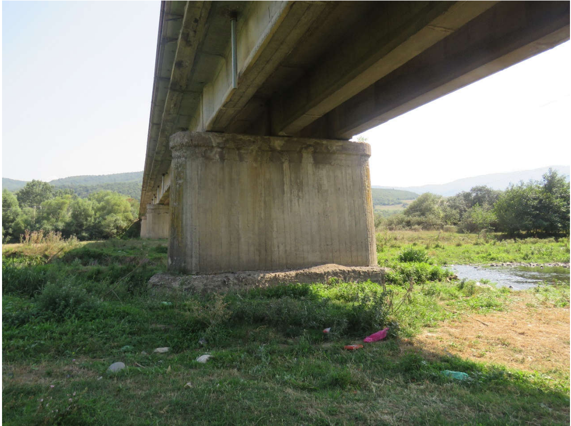
სურ. 3. ჩასაშვები ჭის გამოფიტული ბეტონი
