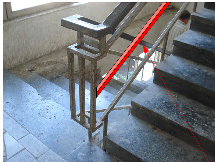
Sida kibis moaj irebs yvel a marSze, usafrTxoebis mizniT, daematos TiTo Reri mil kvadrati kveTiT 30X30 mm.
